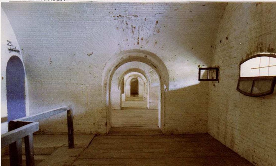
Particolare delle volte a crociera (foto sopra) e della voltatura a botte (foto a lato)
